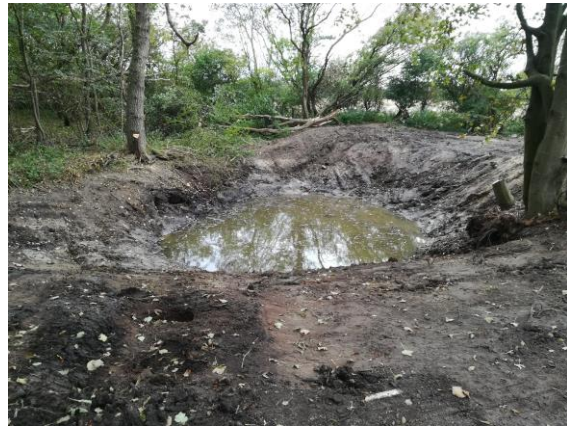
Teich nach Sanierung
